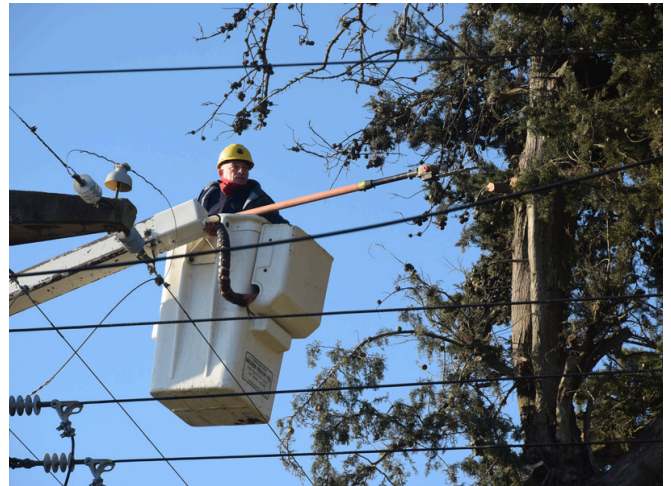
Trabajador de la Cooperativa Eléctrica de Monte realizando tarea de Poda.
