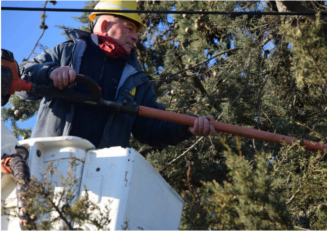
Trabajador de la Cooperativa Eléctrica de Monte realizando tarea de Poda.
